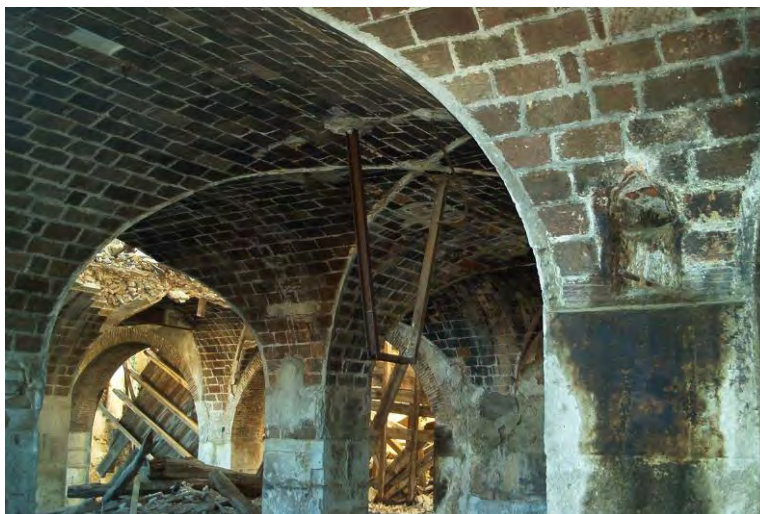
FIGURA nº6: Interior de la fábrica de Tort, en primer plano bóvedas de arista o de 20 palmos y al fondo suelos de madera.
