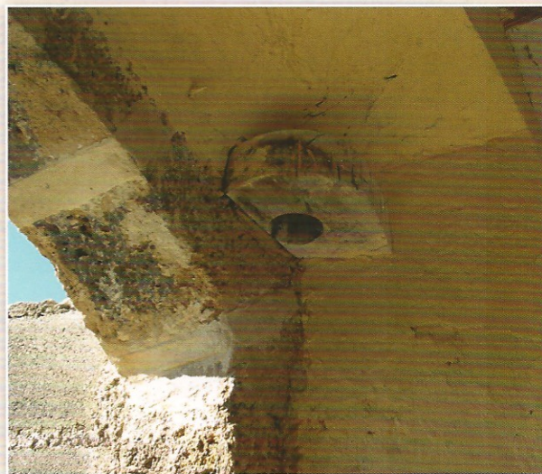
Quicio de madera de una de las hojas de la puerta, empotrado en los muros.
