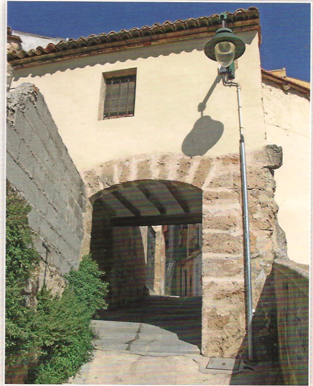
La Puerta del Forn del Vidre , vista desde el exterior.
