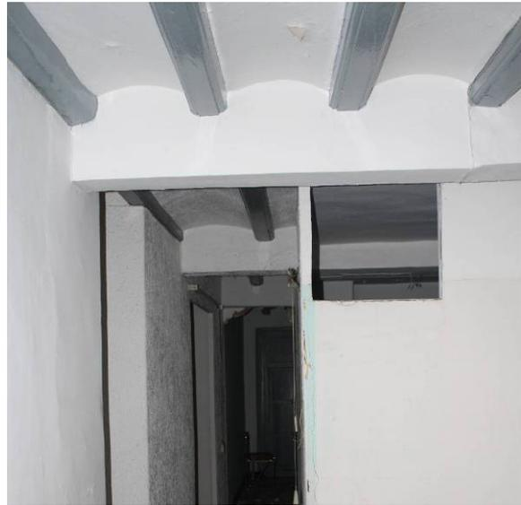
*Imagen del tipo de estructura adintelada de los edificios del modelo de transición*
